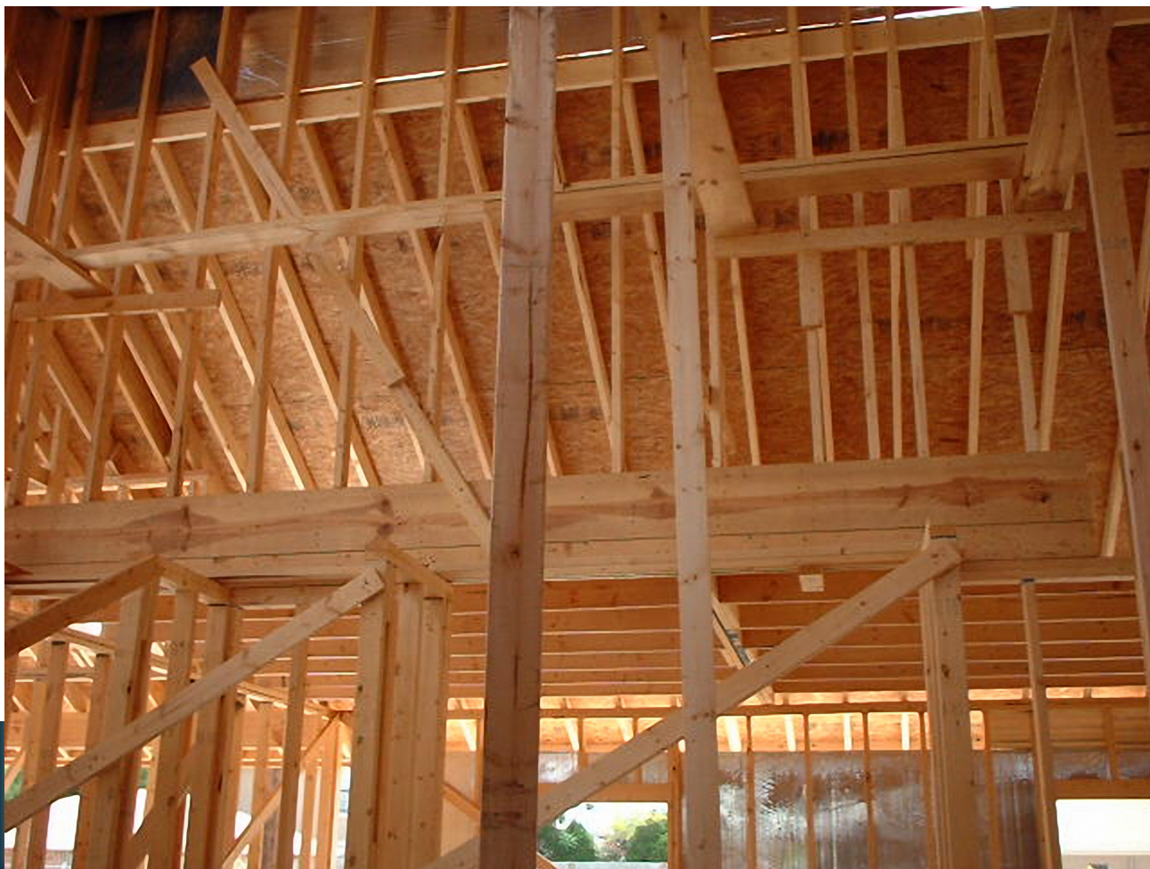
Estructura de entrepiso.
