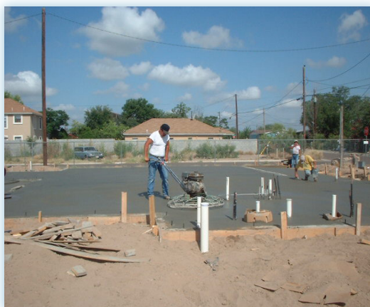
Compactación y armados.
