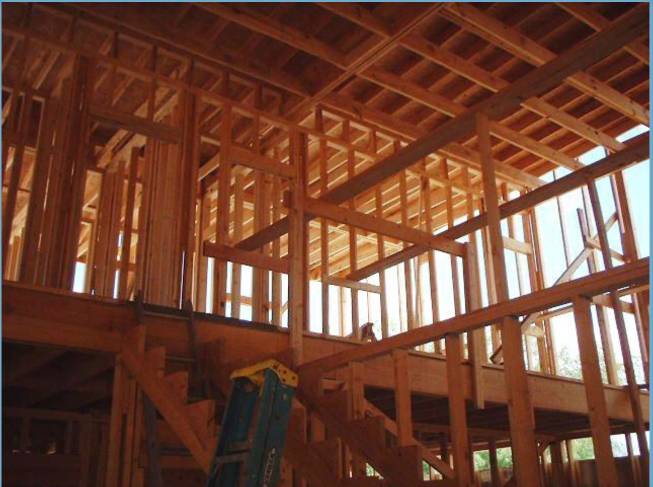
Estructura de losa plana.
