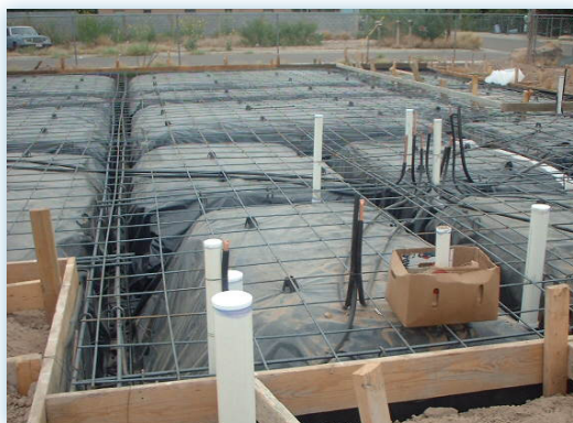
Losa de cimentación.
